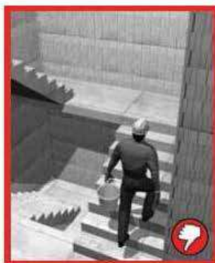
Provést zábradlí v prostorech se schodišti
