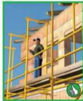
Převzetí kompletního lešení se všemi konstrukčními prvky Práce ve výšce se zábradlím
