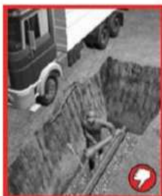
Neukládat materiál (nejezdit) na hranu výkopu
