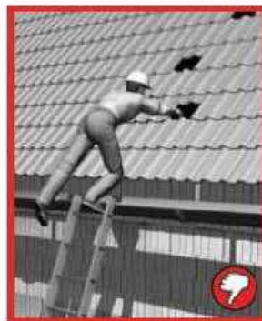
Přesah min. 1,1 m nad výstup/práci
