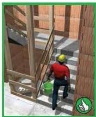
Provést zábradlí v prostorech se schodišti
