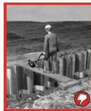
Přes výkop postavit lávku. Výkop se nesmí přeskokovat.
