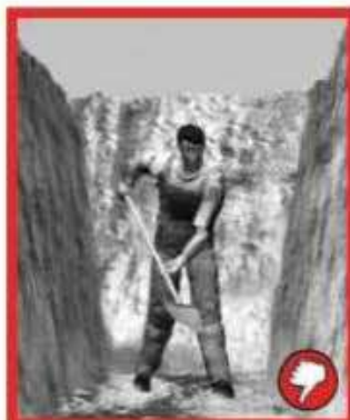
Výkop ruční do 1,3 m hloubky, není nutno zřizovat pažení. Doporučuje se výkop svahovat.
