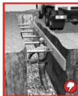
Výkop zajistit pažením. Neukládat materiál (nejezdit) na hranu výkopu.
