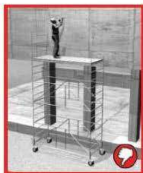
Zajištění – práce ve výšce se zábradlím, aretace pojezdu
