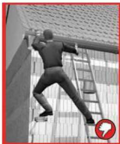
Pracovník se nesmí vyklánět + zajistit přesah 1,1 m
