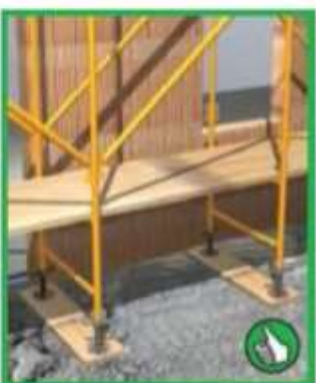
Dostatečně únosné a stabilní podloží
