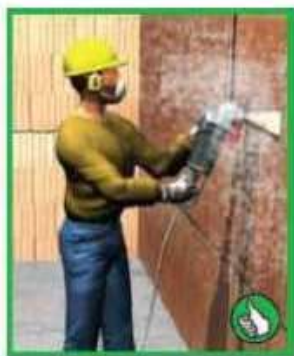
Řezání / broušení s maskou a rukavicemi
