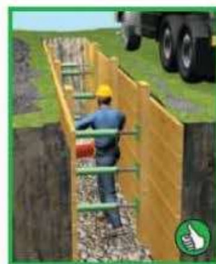
Výkop zajistit pažením. Neukládat materiál (nejezdit) na hranu výkopu.
