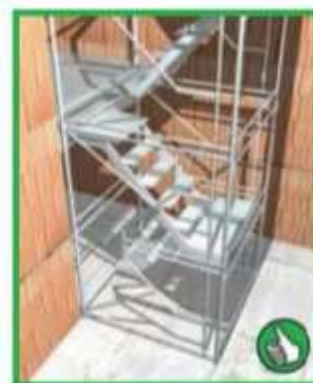
Komunikace a práce ve výškách vždy na dostatečně stabilních konstrukcích – např. pomocí lešení, příp. žebříkem, splňující předpisy
