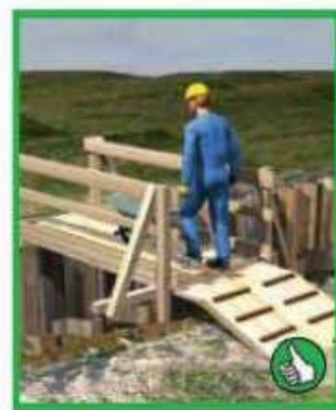
Přes výkop postavit lávku. Výkop se nesmí přeskokovat.
