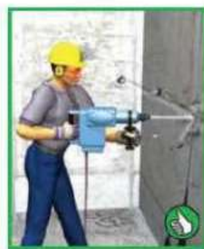
Vrtání / broušení s brýlemi a rukavicemi
