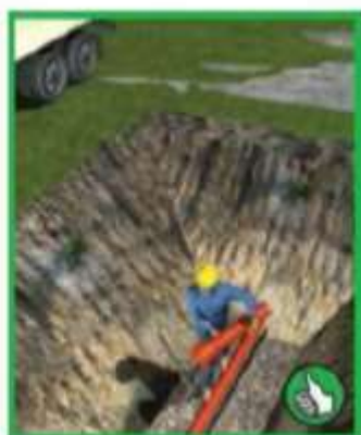
Neukládat materiál (nejezdit) na hranu výkopu
