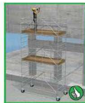
Zajištění – práce ve výšce se zábradlím, aretace pojezdu
