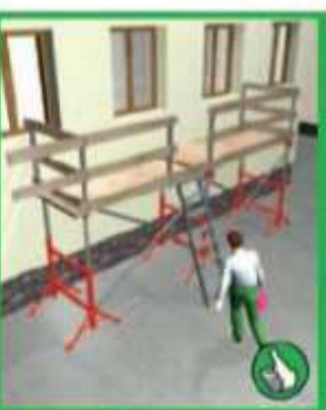
Zajistit dostatečně stabilní pracoviště, vč. zábradlí – HROZÍ PÁD!
