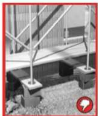
Dostatečně únosné a stabilní podloží
