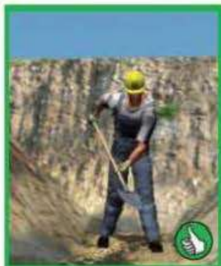
Výkop ruční do 1,3 m hloubky, není nutno zřizovat pažení. Doporučuje se výkop svahovat.
